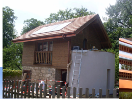
Chantier du carnotzet de Presinge
