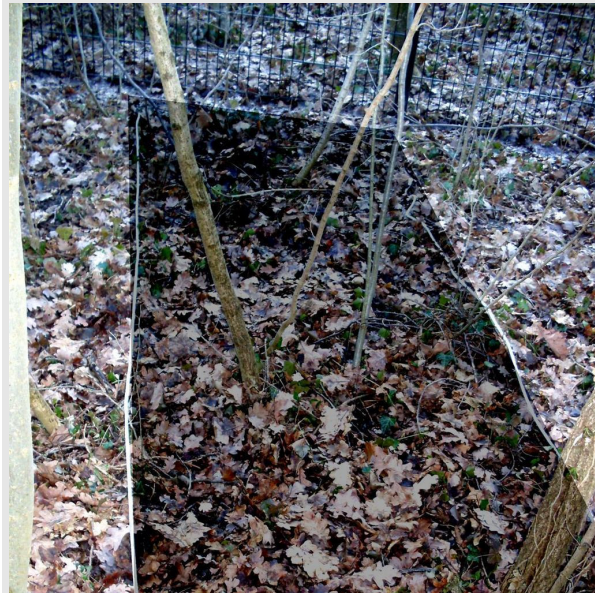
La tracé du mur se poursuit en direction de la barrière métallique de la parcelle voisine.
