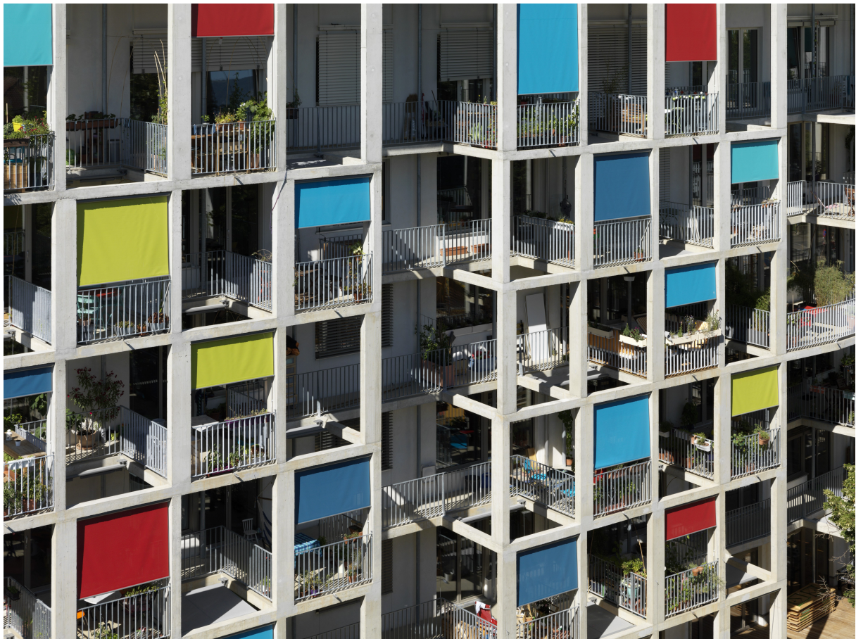
Façade sud de Soubeyran 7 conçue par le bureau ATBA
