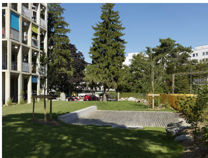
Fameuse terrasse recouvrant les cuves à lombricompostage
